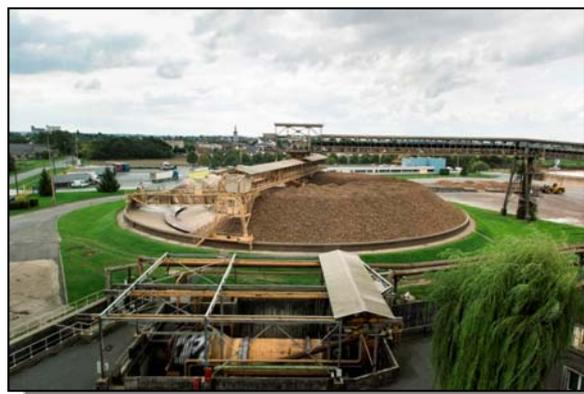
Les betteraves doivent être travaillées rapidement pour éviter les détériorations. Le stock de betteraves de l'usine garantit une autonomie de 48 heures à l'usine qui fonctionne en flux continu.
